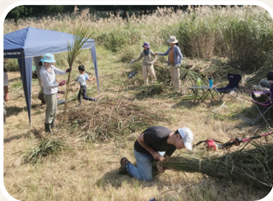
バイオトイレ屋根の材料にススキを収穫中
