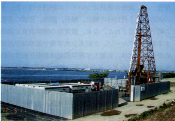
第4図. 烏丸地区の深層ボーリング工事現場. 右端の檣は大型掘削機用.
