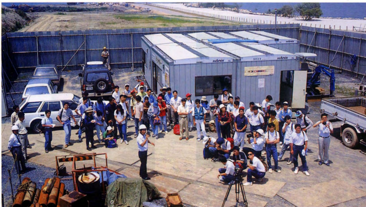
ボーリング調査現場の見学会
