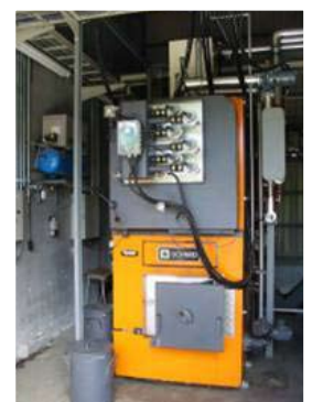
チップボイラー
