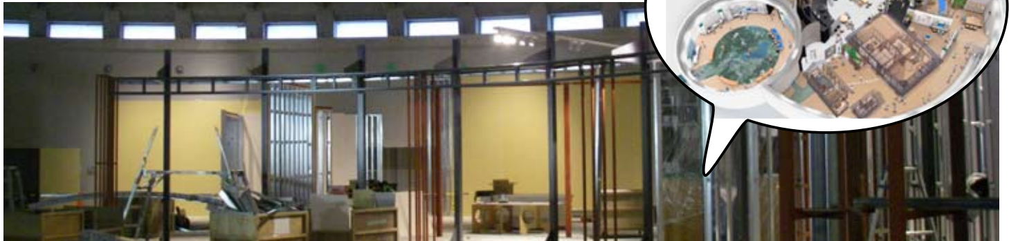
C展示室：工事の現況
