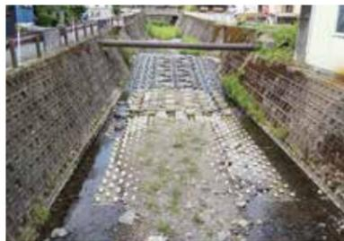
写真2. 全面魚道に改修された落差工
