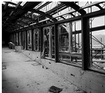
水族棟渡り廊下鉄骨施工 ( '95.10.26)
