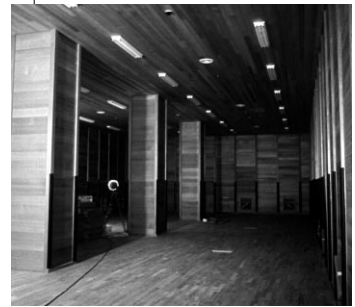
収蔵庫床下リソク貼施工 ( '95.9.28)
