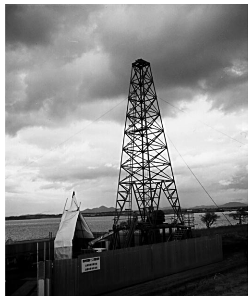
「地下1000mの記録」で 再現されたボーリング調査風景
