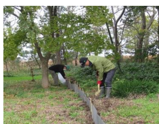
波板が倒れないように竹で補強
