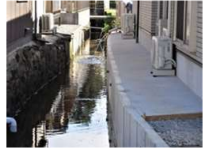
□各戸より水路へ放出様子
