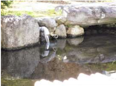
□ 能登川支所の遊水池
