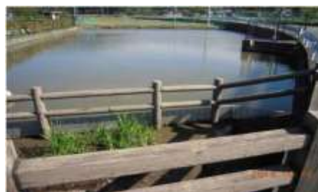
新蛇砂川出水地点の防火池
