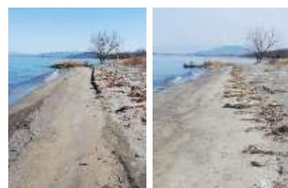
浜欠の状況 左: 現在の様子 右: 2019. 2・18日の様子
