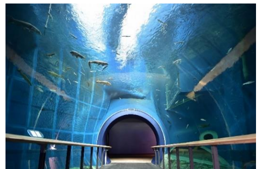
アクリル交換前のトンネル水槽の様子
