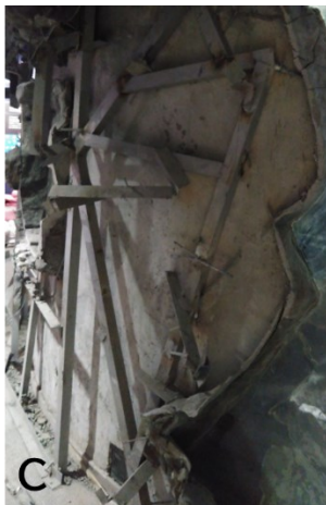
図26 水槽背面の状況 A・B:アクリルに塗布されたモルタル。あちこちにひび割れが生じている。C:擬岩を設置する鉄骨。鉄骨の一部はモルタルに接している。D:擬岩とアクリルの端を隠すために施されたシリコン。擬岩とアクリルの間の緩衝材にはなっていない。
