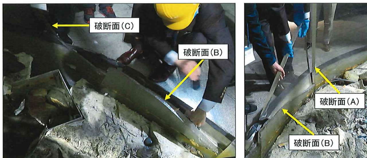
図9 水槽内側から見た躯体部分のアクリル水槽の様子
