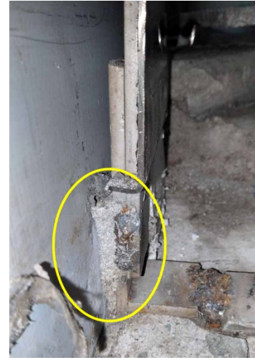
図25 L字金具の接触 状態
