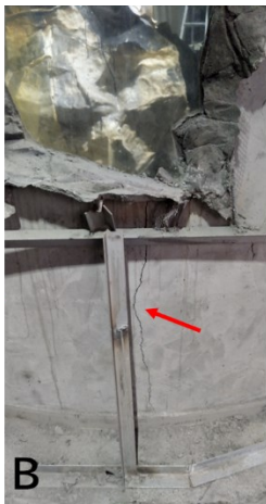
図26 水槽背面の状況 A・B:アクリルに塗布されたモルタル。あちこちにひび割れが生じている。C:擬岩を設置する鉄骨。鉄骨の一部はモルタルに接している。D:擬岩とアクリルの端を隠すために施されたシリコン。擬岩とアクリルの間の緩衝材にはなっていない。
