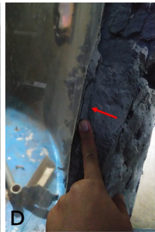
図26 水槽背面の状況 A・B:アクリルに塗布されたモルタル。あちこちにひび割れが生じている。C:擬岩を設置する鉄骨。鉄骨の一部はモルタルに接している。D:擬岩とアクリルの端を隠すために施されたシリコン。擬岩とアクリルの間の緩衝材にはなっていない。
