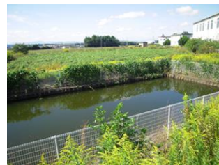
揚水機横の貯水槽
