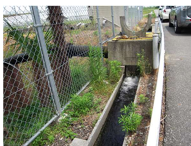
□道路脇の用水路全貌
