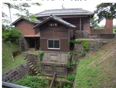
□龍ヶ池揚水機場全景
