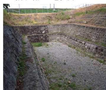
□枯れた砂山池
