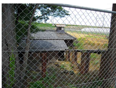
□金網越し砂山池揚水機場
