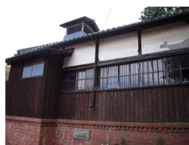
□揚水場建屋を裏側から
