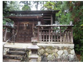
■稲荷神社本殿の二重屋根
