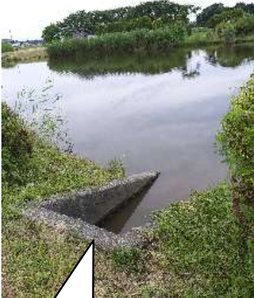
五反田沼には取水口が設置されている(農業用水として利用)
