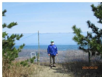
防風ネット設置後
