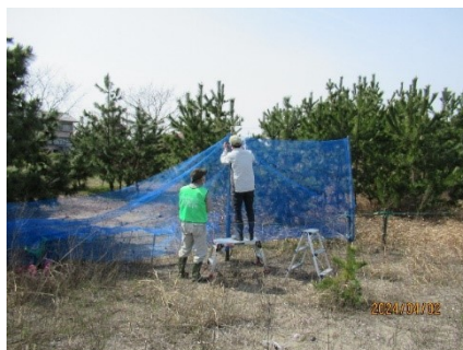
防風ネット設置中
