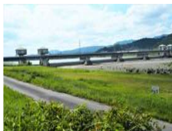
□石部頭首工下流域からの全景
