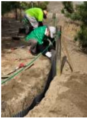
保護区内に地下茎侵入防止波板設置作業
