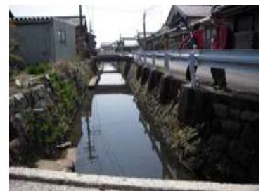
舟を引き上げる時の通路跡
