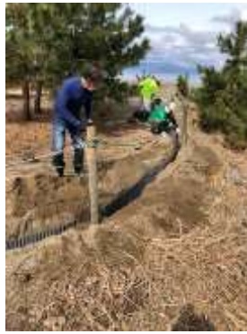
保護区内に地下茎侵入防止波板設置作業
