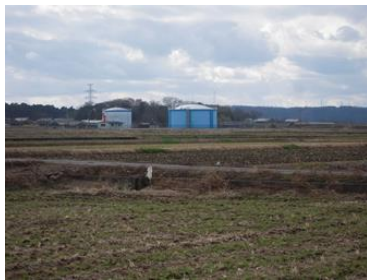
□上水道低位配水タンク
