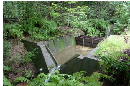
写真 2. 流出水量の観測の様子
